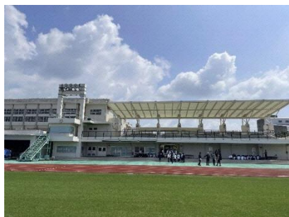
メインスタンド (金武町陸上競技場)
