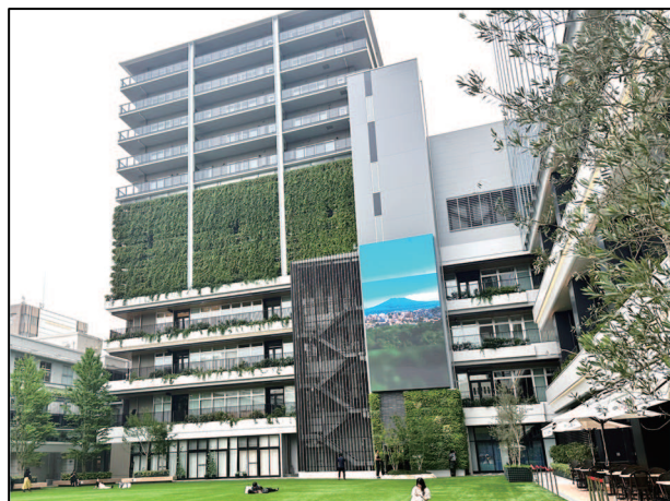
低層階に商業施設がある集合住宅
