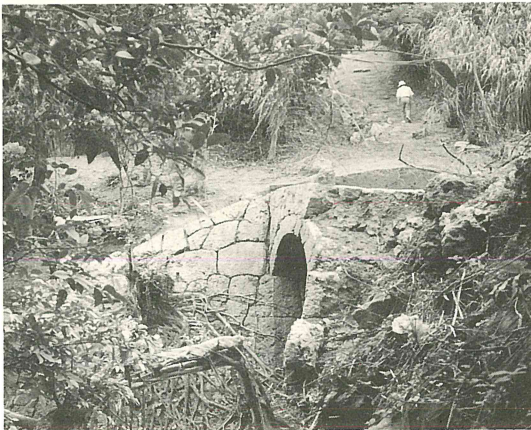
一部損壊している安波茶石橋の基
