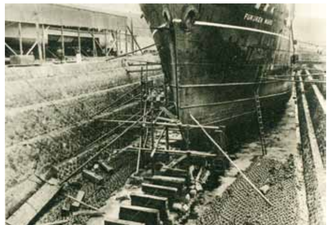
▲基隆港の拡張整理とともにできたドック （『臺灣紹介 最新寫真集』勝山吉作編、勝山寫真館、1931 年）
