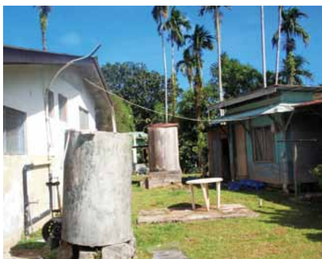
▲日本人の使用していた水タンク (パラオ、仲地清撮影、2012 年)
