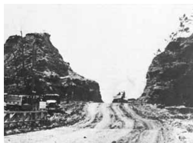
牧港橋付近の工事『浦添のあゆみ』73頁
