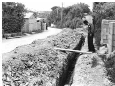
経塚水道管配管工事（1967年） 浦添市立図書館所蔵
