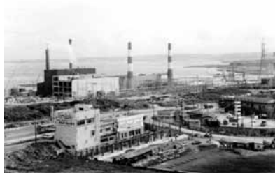
牧港火力発電所（1960年代） 浦添市立図書館所蔵
