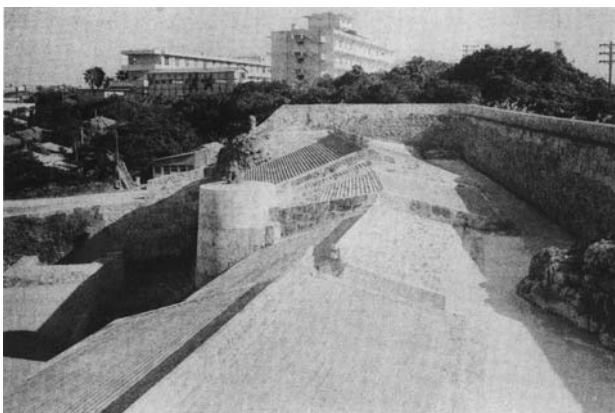
写真1 玉御殿屋根と自然岩B(西から撮影) (文化財建造物保存技術協会、1977)
